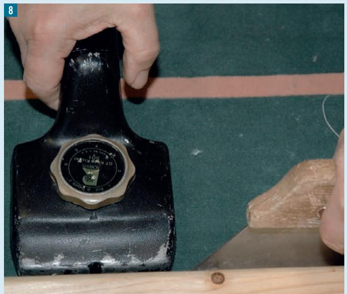
**1** Um das Konfektionieren zu üben, werden die Nähte des zu verspannenden Textilbelags mithilfe einer Ahle entlang der Florgasse geöffnet, ehe der Acrylschneider (nicht im Bild) zum Einsatz kommt.
